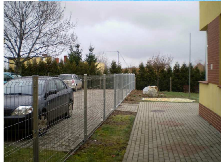
Ogrodzenie od strony parkingu w Piotrowicach
