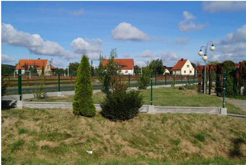
Ogrodzenie od drogi powiatowej w Męcince
